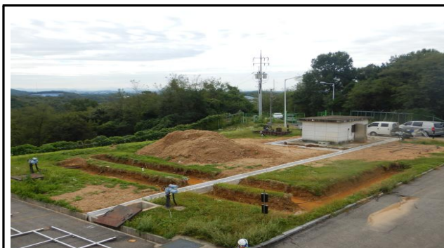
배수지 상부 전경 (2021년)
