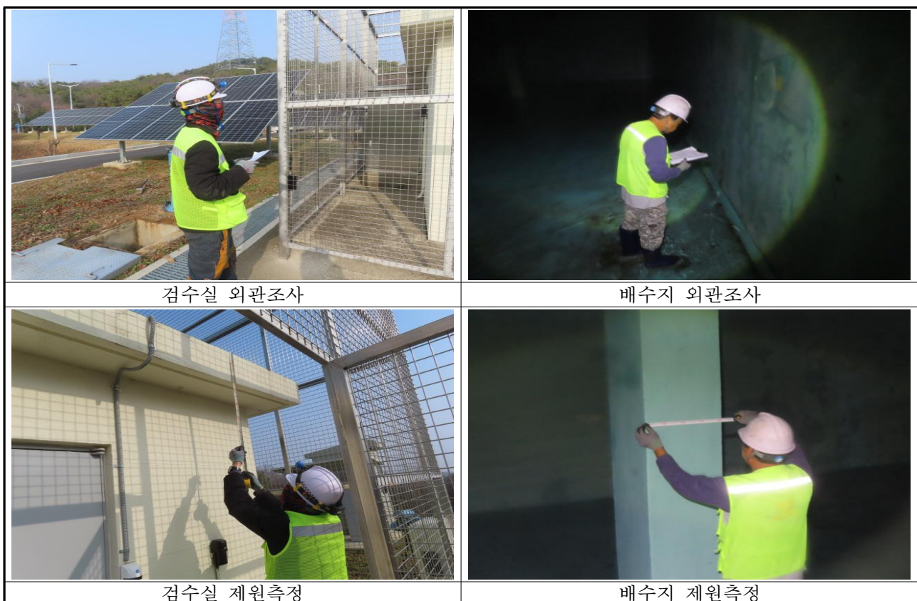
【사진 3.1】 시설물 외관조사
