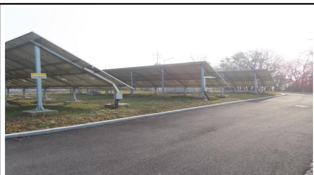
배수지 상부 전경 (2023년)
